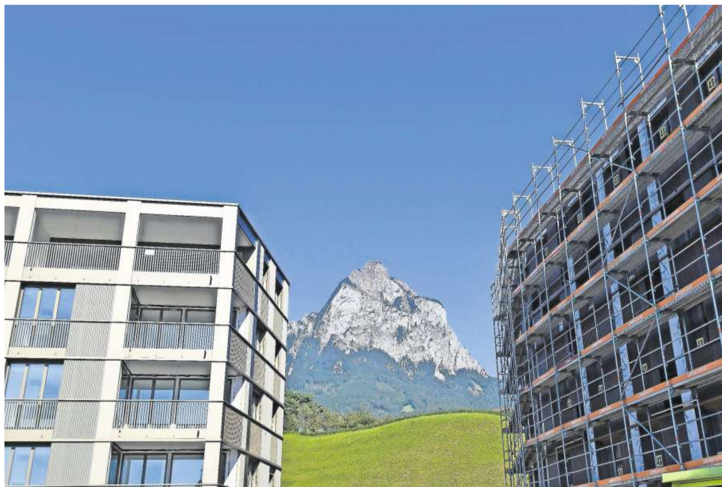
Baustelle im Hof in Ibach: Verdichtetes Bauen wird auch in der Region Schwyz zunehmend ein Thema.
